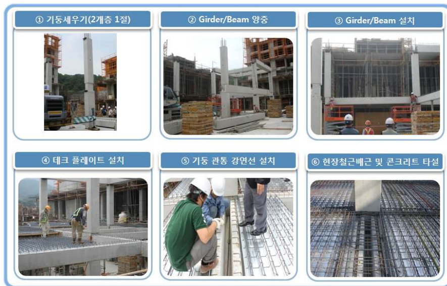
강연선PC 공법 시공순서
